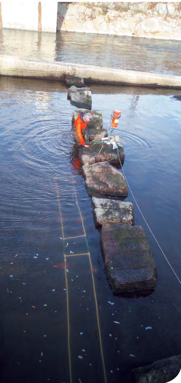
12 | Montaż anteny w szczelinie migracyjnej w miejscowości Gorlice, rzeka Ropa fot. Archiwum ZBE
