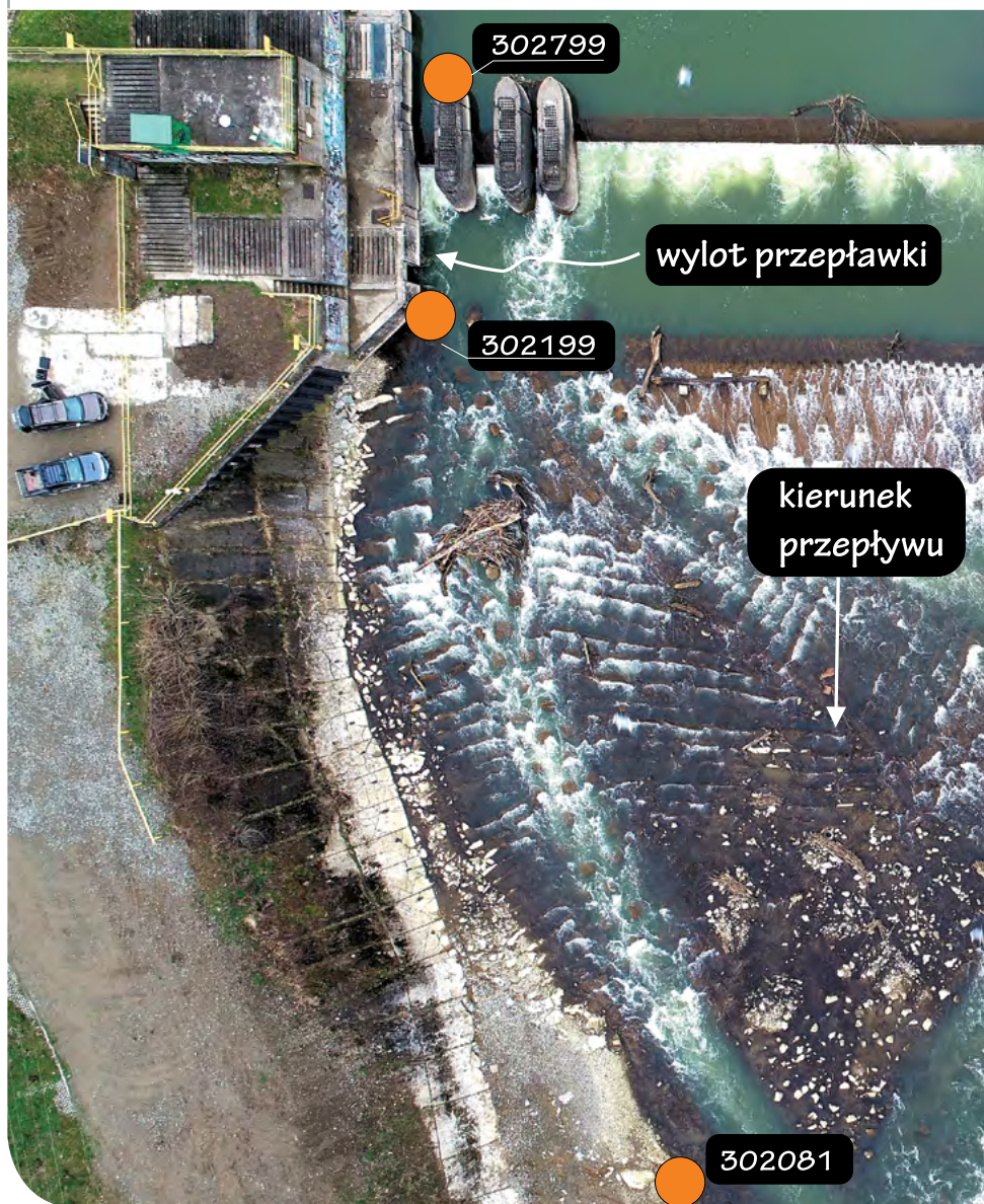
10 | Rozmieszczenie hydrofonów. Przeławka w miejscowości Dębica fot. Archiwum ZBE
