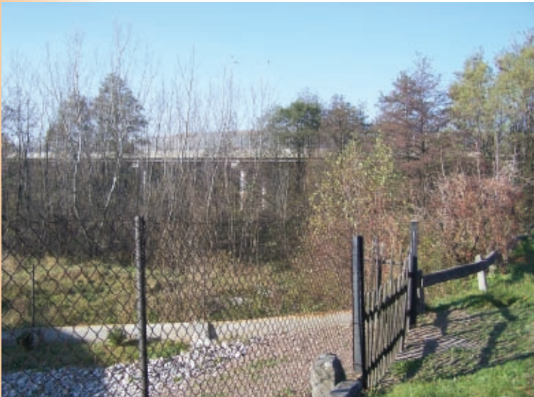
Przeście pod mostem autostradowym wychodzące wprost na ogrodzenie z siatki drucianej – przykład przejścia, które nie może poprawnie funkcjonować
