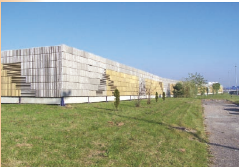
Ogrodzenie Autostrady A4 pod Krakowem, uniemożliwiające przemieszczanie się zwierząt
