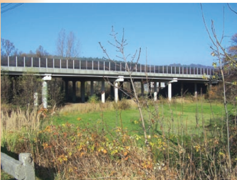
Zakrzaczony teren pod mostem autostradowym, mogący spełniać rolę przejścia dla zwierząt
