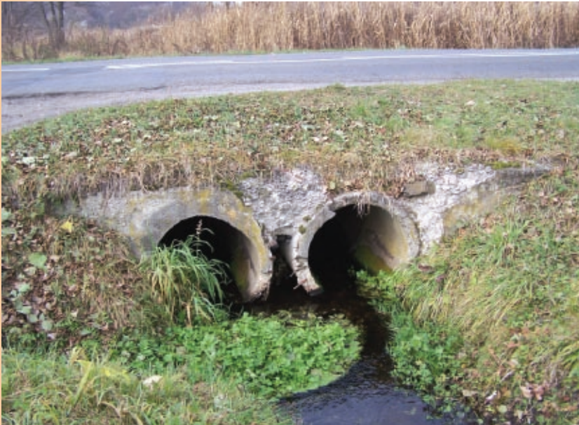
Przepust pod drogą, który nie może pełnić funkcji przejścia dla zwierząt
