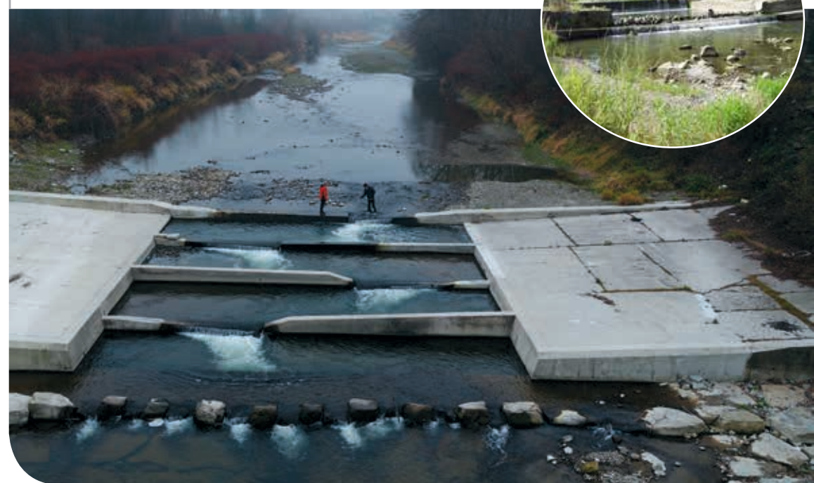
8 | Stopień w Białej Niżnej II – przed modernizacją (u góry) i po (u dołu) fot. Zakład Badań Ekologicznych
