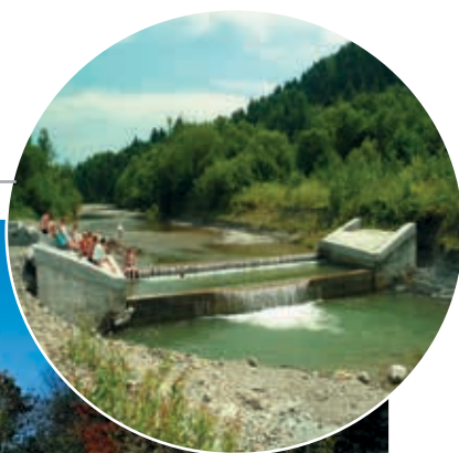
13 | Stopień Florynka III przed modernizacją (obok) i po przebudowie (poniżej) fot. Zakład Badań Ekologicznych
