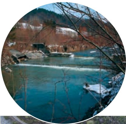
12a | Stopień Florynka I przed modernizacją fot. Zakład Badań Ekologicznych
